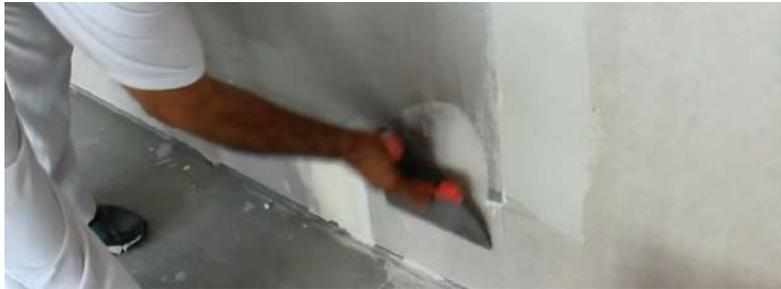
Une fois cette pâte sèche, nous placerons du ruban de fibre de verre entre la plaque et le mur, en suivant tout le périmètre de la plaque. Cela sert à absorber une éventuelle dilatation thermique.
