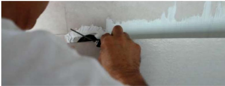
Après avoir été correctement réglé, appuyer sur toute la surface de la plaque afin d'éliminer d'éventuelles poches d'air entre la plaque et le mur. La pression doit être appliquée horizontalement sur le placement de la plaque, dans la zone la plus étroite.
